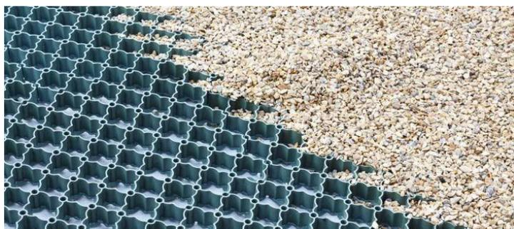
Stabilisé avec grille alvéolaire stabilisatrice
