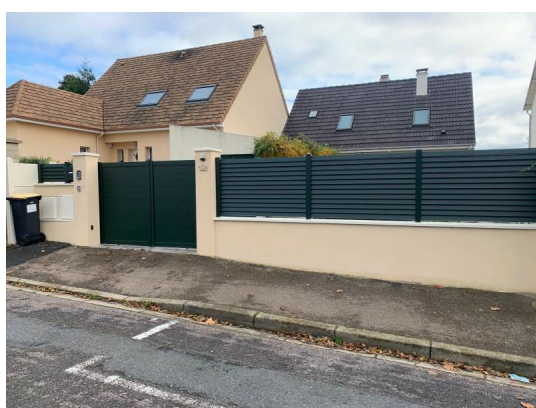
Soubassements de clôture et murets maçonnés
